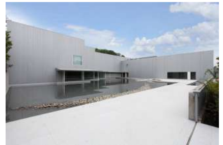
長野県立美術館（東山魁夷館）外観
