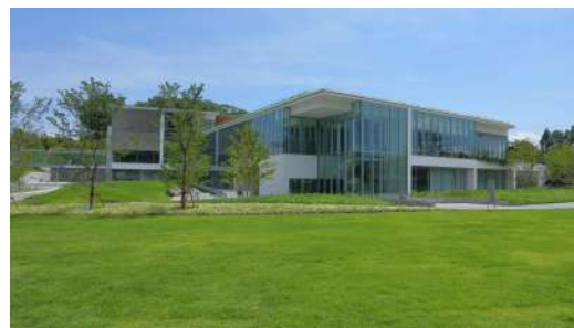
長野県立美術館（本館）外観
